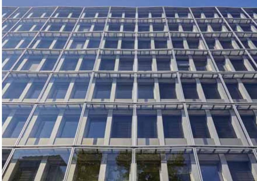
Pour donner du caractère à l'ensemble, nous avons choisi de créer une double peau en verre avec des modules de 3 mètres de côté. Ce système a permis de contribuer à la régulation thermique des pièces et changer le caractère et l'identité du bâtiment. Afin d'amplifier les performances énergétiques, nous avons
